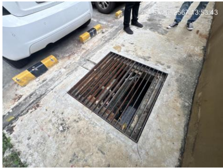
บ่อพักน้ำทิ้งสุดท้ายก่อนระบายออก รูปที่ 2.1-10 ระบบระบายน้ำโครงการ
