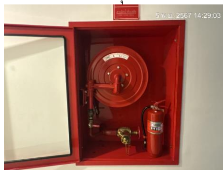
ตู้ FHC และป้ายแสดงวิธีใช้อุปกรณ์
